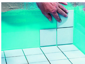
Vattenisolera Sauna-Satu enligt tätskiktstleverantörens anvisningar. Montera golvklinkern.
