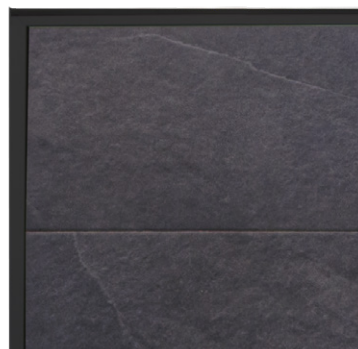
Stenvägg med svart aluminiumram.
