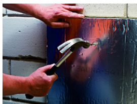
Sauna-Satu lämpar sig väl för montage på både trä- och stenkonstruktioner. Montera skivan med datumtexten mot basturummet. Fäst isoleringsskivan lätt med lämplig infästning beroende på underlag.
