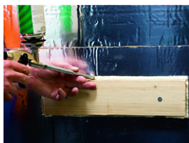
Skär ut en bit av isoleringsskivan, lite större än bastulavens stödbredda. Fäll in stödbredda genom isoleringen, fäst in i väggen och täta med fogs-kum.
