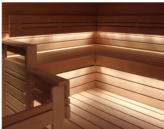
Ljuslister monterade bakom ryggstöd och under bastulavens fronter.
