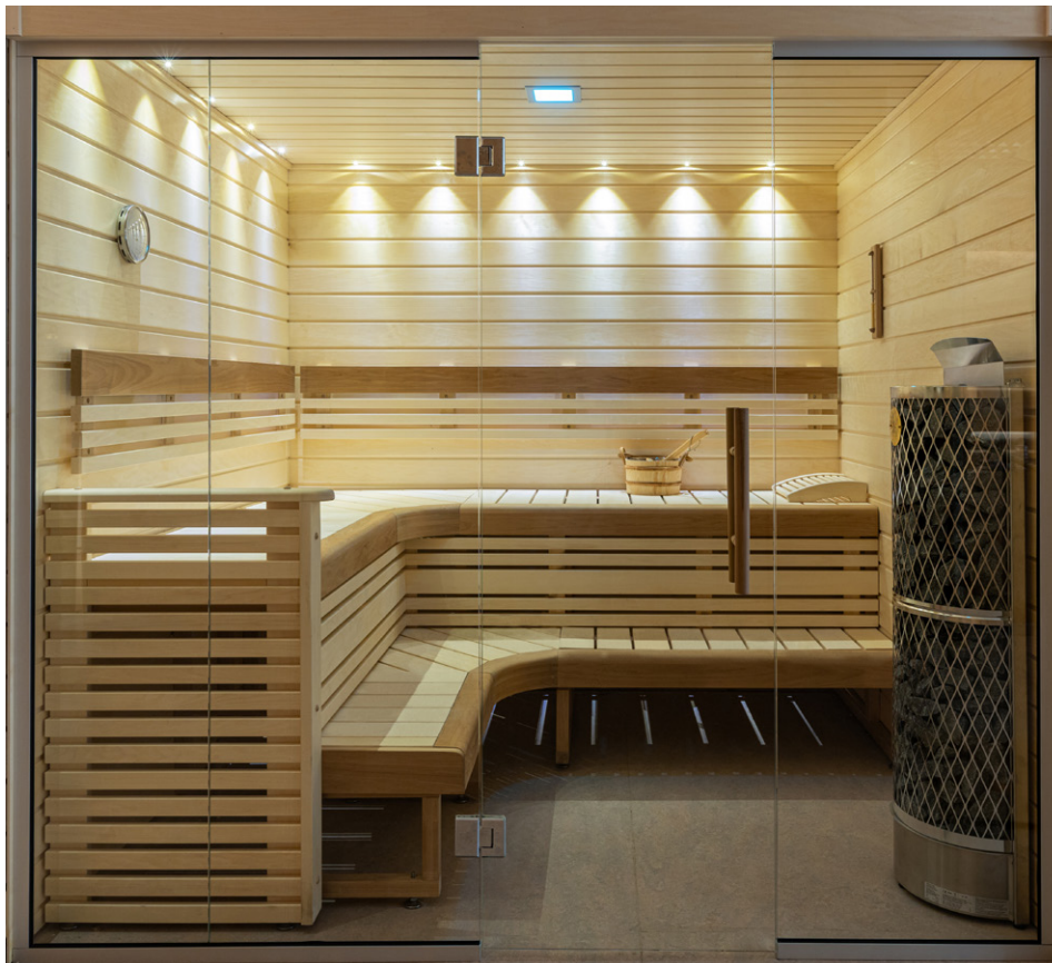
Glasen har monterats som en frontvägg helt i glas med aluminiumskenor och kromade gångjärn. Handtag i kombination trä/krom.
