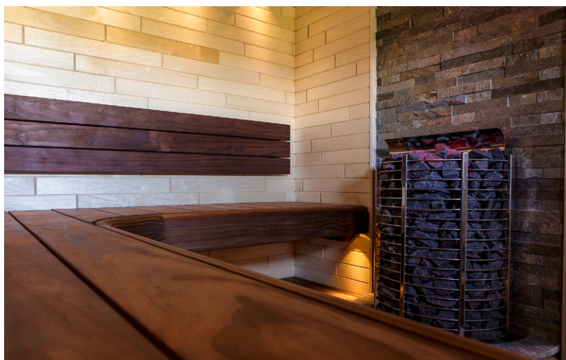
Bastuinteriör i Radiata Pine, på väggen ändspontad asp. Vägg bakom aggregatet har dekorsten.
