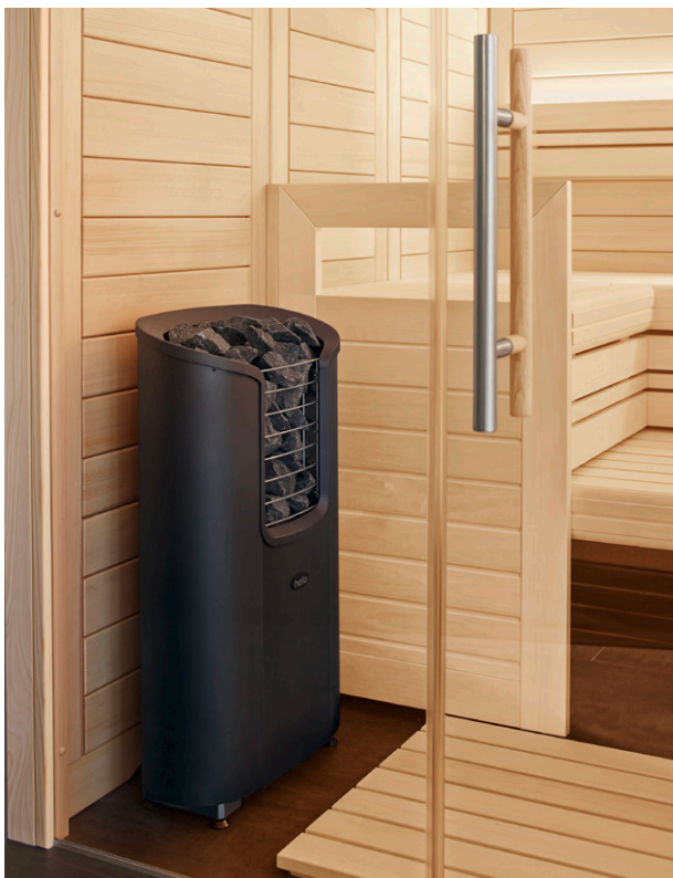
Bastuinredning tillverkad i asp. Panel på bastuns väggar och tak i 15x90 mm asp.
