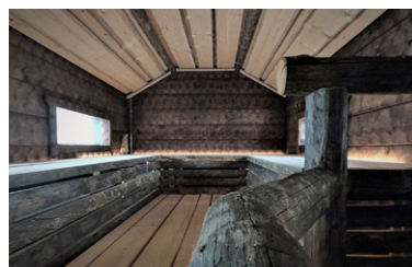
Tak i okantad Kelo-panel monteras som lock panel.
