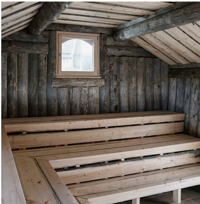
Vägg med stående Kelo halvtimmer och bastuinredning i Kelo lavevirke.
