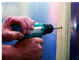
Montera läkten, med lämplig infästning, ovanpå isoleringen. Luftspalten under panelen skall vara minst 20mm.
