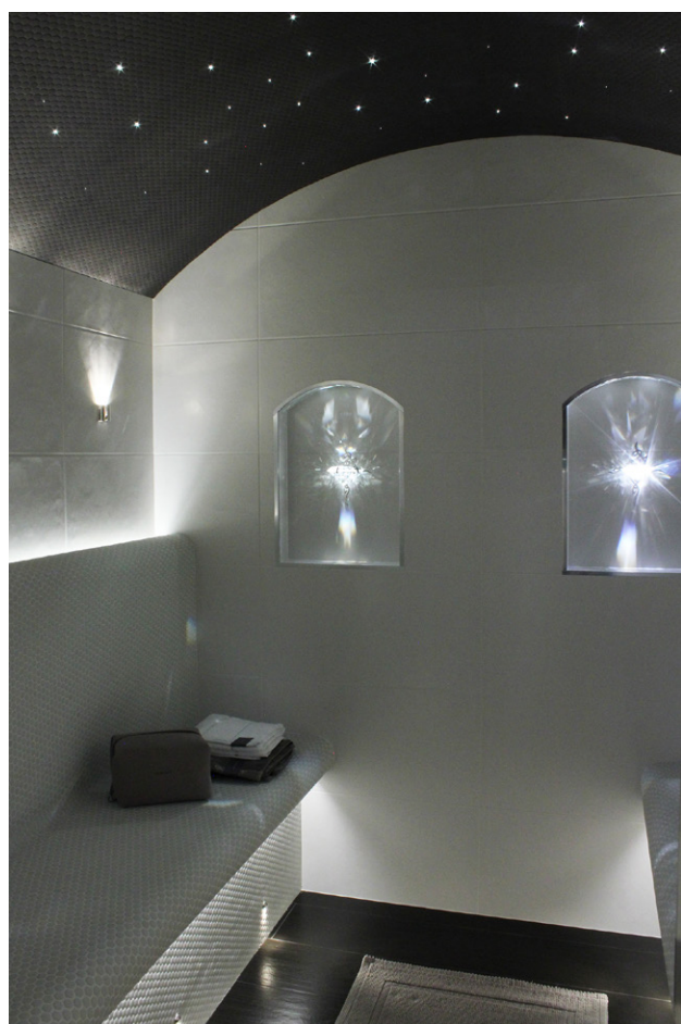
Ångrum med SY armatur på vägg, GP-65 under bänk, CR-05 bakom ryggstöd och Kihla monterad i fönstermisch.
