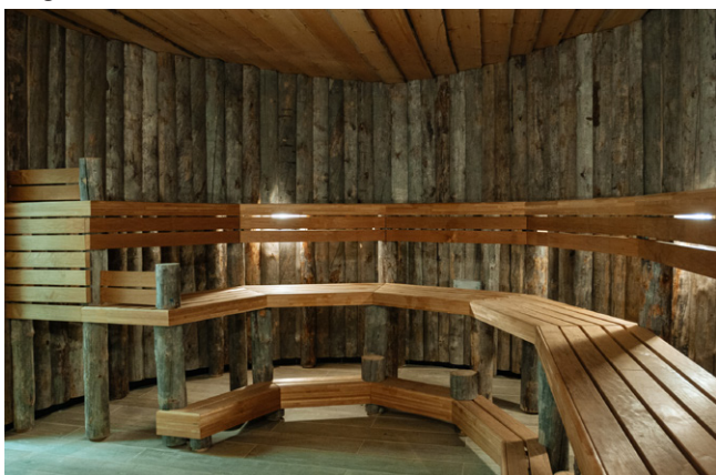
Vägg med stående Kelo halvtimmer, bastulaven är tillverkad i värmebehandlad asp.
