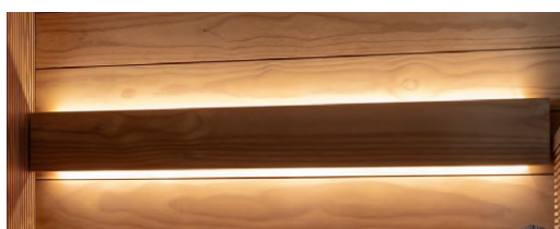
Ryggstödsbräda förberedd för LED-belysning
