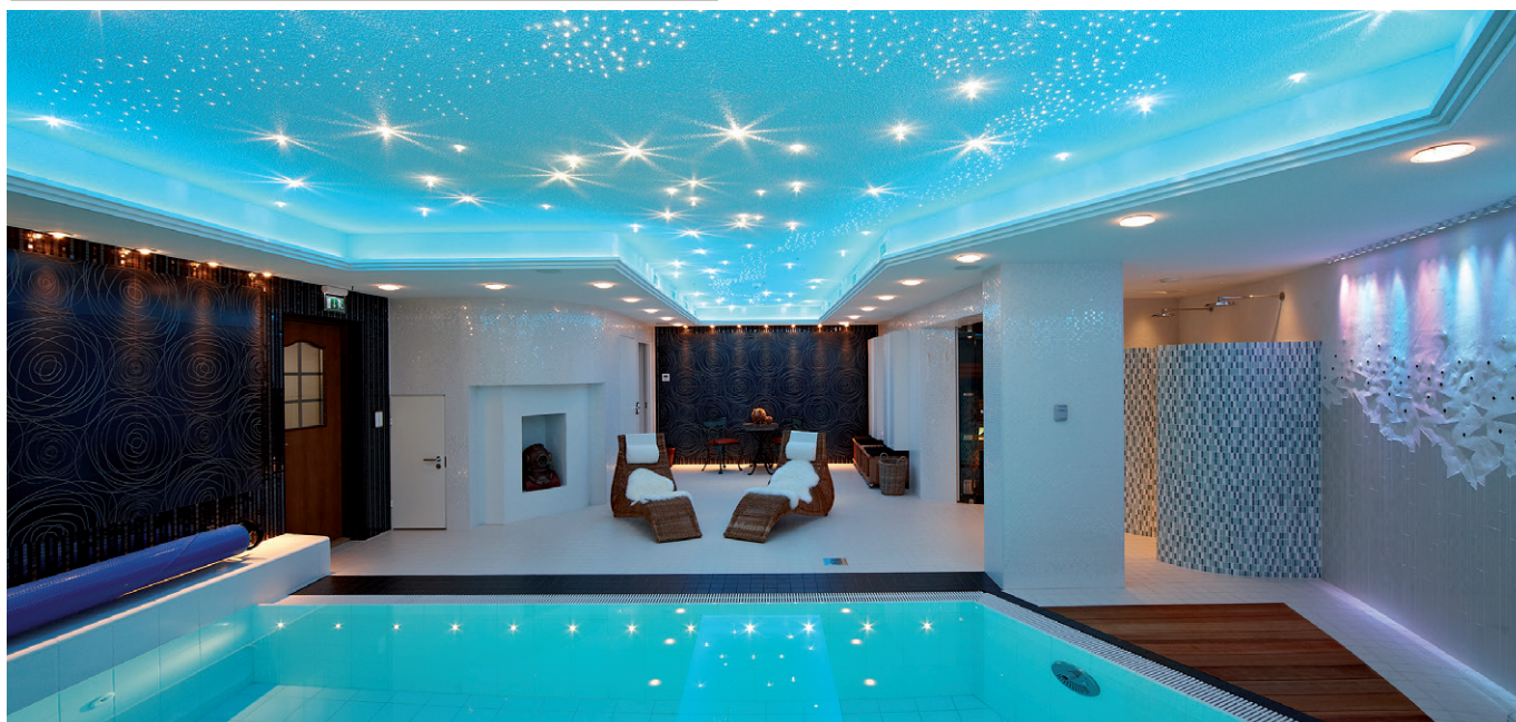
S-Paver ljusfiberarmatur monterad i pool, stjärnhimmeln i taket är av typ Crystal Star, i dessa paket finns fiber med och utan kristaller.
