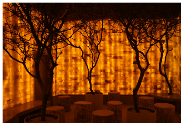
Färgen och intensiteten på ljuset bakom saltstensväggen kan varieras med RGBW LED-belysning.
